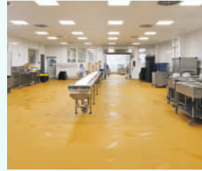
PU CONCRETE FLOORING
